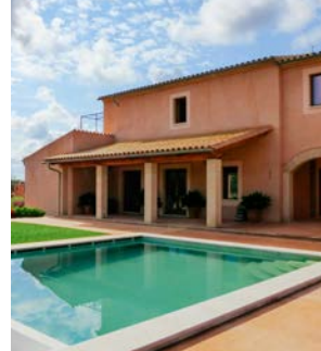
Tasokas huvilan passiivenergiakunnostus, "Proyecto Tierra" Lluçmajorissa Mallorcalla,
